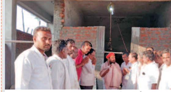
హనుమాన్ ఆలయ పునర్నిర్మాణ పనులను పరిశీలిస్తున్న వీరాధిపతి
